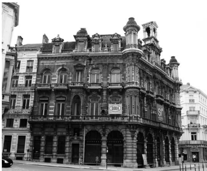
Hoek Congresstraat/Vrijheidsplaats, gebouw van de Banque Industrielle Belge van baron Edouard Empain. (FOTO AUTEUR)
