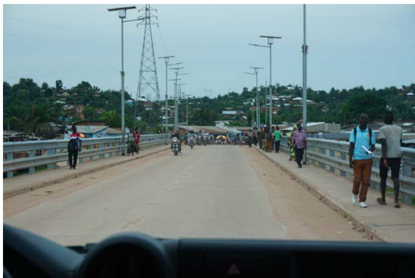
De nieuwe brug over de Lukuga
